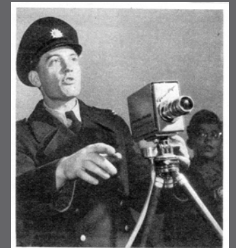
Etwas größer als eine Zigarrenkiste ist diese Fernseh-kamera, die von Europas größter Radiofabrik, Grundig, entwickelt wurde. Das leicht zu transportierende Gerät kostet etwa ein Fünftel der bisher üblichen Kameras. Es eignet sich zur polizeilichen Kontrolle des Straßenverkehrs (zum Beispiel an gefährlichen Kreuzungen), zur Über-prüfung von Kesselanlagen in Fabriken, zum Übertragen von Schriftstücken bei Polizei und Bank oder, mit Teleobjektiv ausgerüstet, zur Beobachtung von Grenzabschnitten
