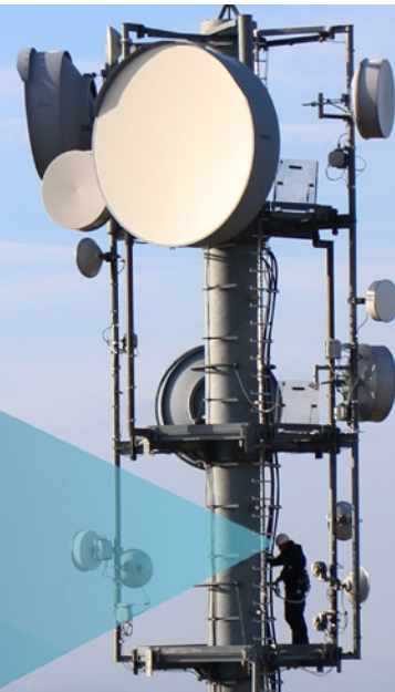
Einsatz auf einer Basisstation in 150 Metern Höhe
